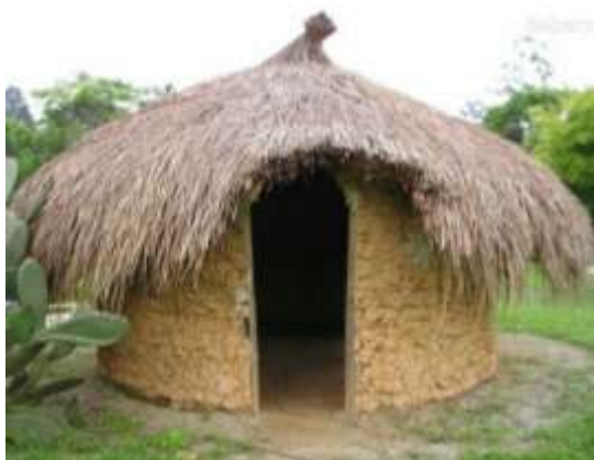
CASA DOS ÍNDIOS - OCA
